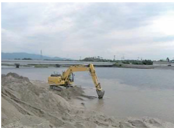
掘削作業状況
