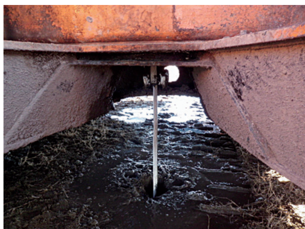
打込後のペーパーの状況
