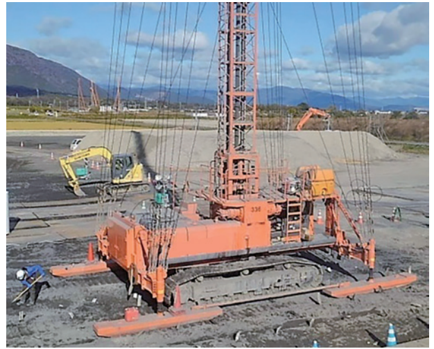
プレファブリケイティッドバーチカルドレーン打機
