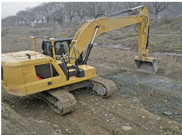
掘削作業状況
