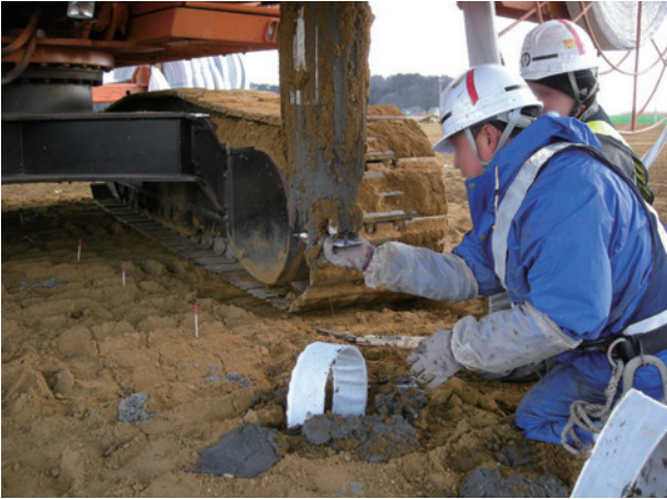
ドレーン材のセット作業状況
