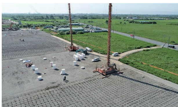
プレファブリケイティッドバーチカルドレーンの施工状況
