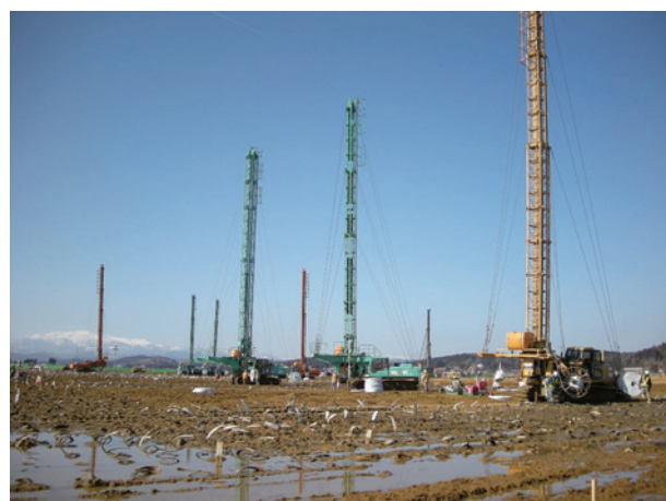
プレファブリケイティッドバーチカルドレーンの施工状況
