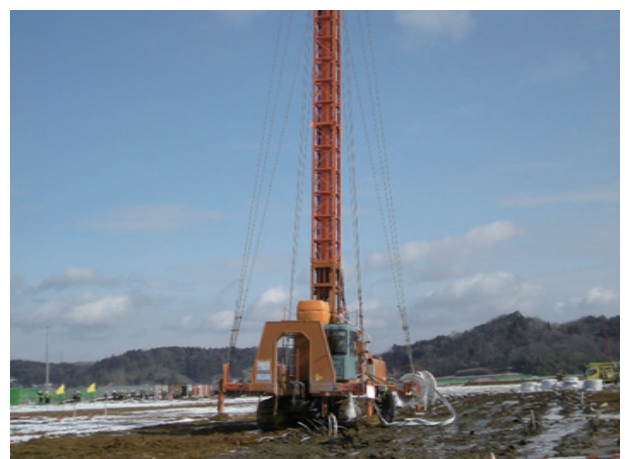
プレファブリケイティッドバーチカルドレーン打機
