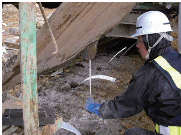
打込後のペーパーの状況
