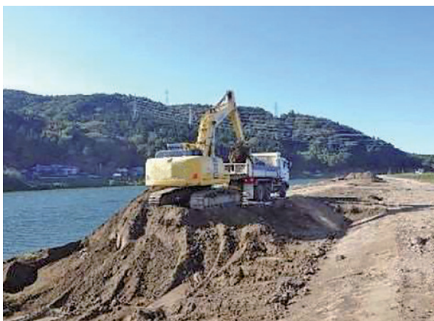
ダンプトラックへの積込作業状況
