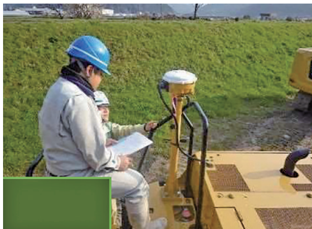
バックホウ (ICT 施工対応型) (参考)
