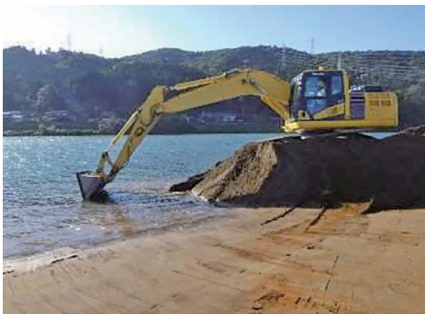
掘削作業状況
