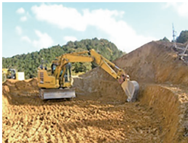
床掘作業状況
