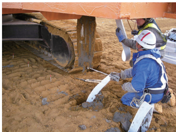
ドレーン材のセット作業状況
