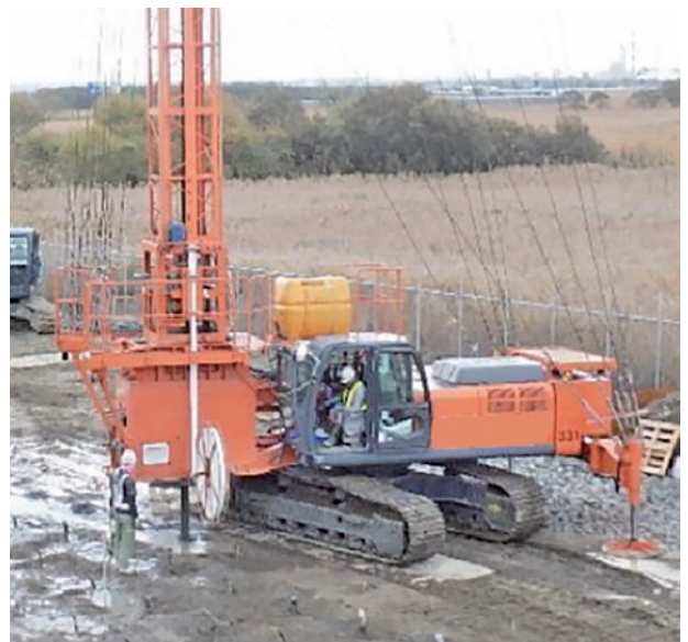
プレファブリケイティッドバーチカルドレーン打機
