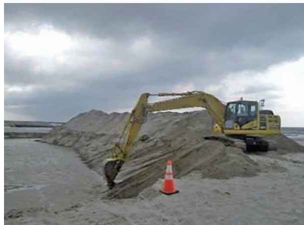
掘削泥土の引寄せ・水切り作業状況
