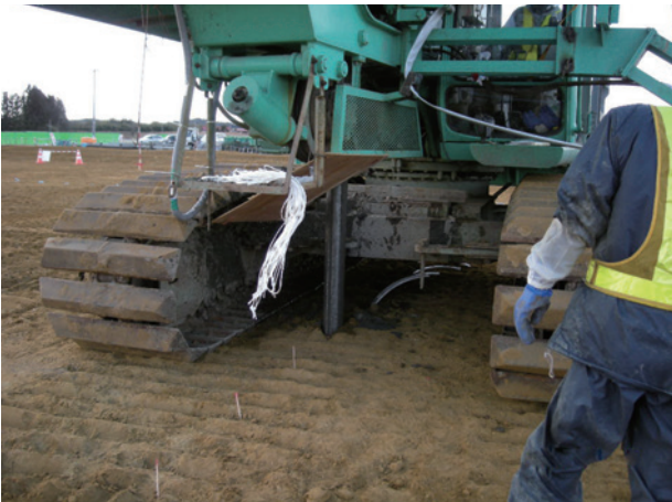
プレファブリケートッドバーチカルドレーンの打込作業状況
