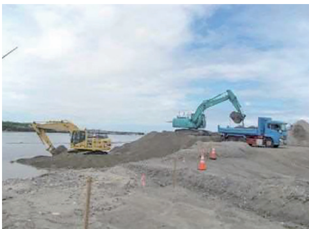
ダンプトラックへの積込作業状況
