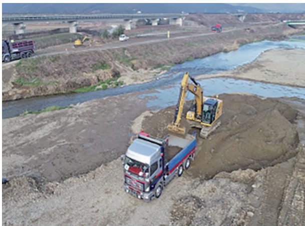
ダンプトラックへの積込作業状況
