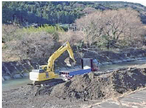
ダンプトラックへの積込作業状況
