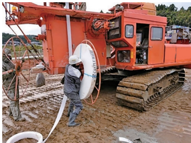
ドレーン材のセット作業状況
