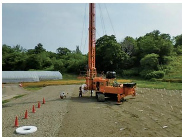
プレファブリケートッドバーチカルドレーンの施工状況
