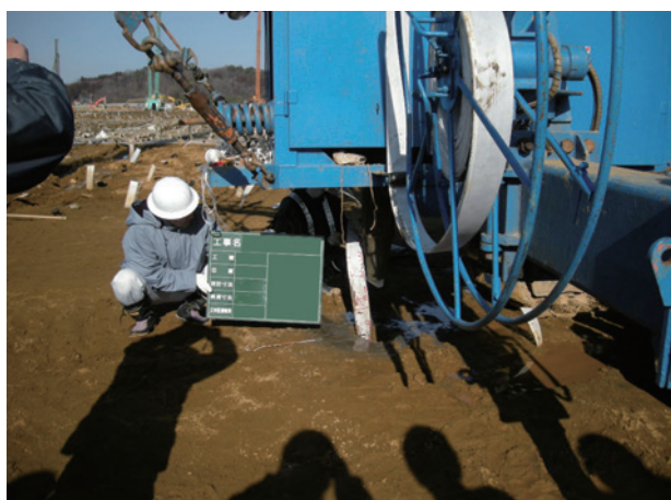
プレファブリケイティッドバーチカルドレーンのキャリブレーション状況
