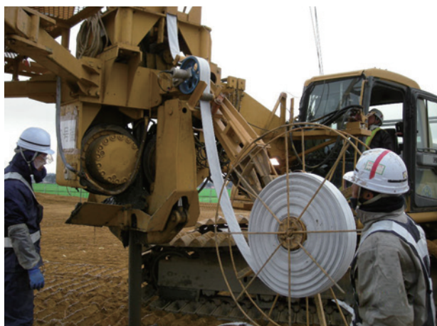
ドレーン材のセット作業状況
