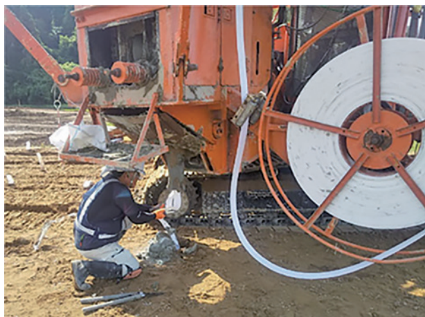
ドレーン材のセット作業状況
