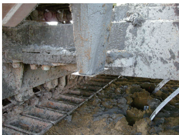
アンカー先端部
