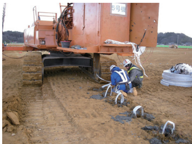
ドレーン材のセット作業状況
