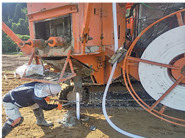
ドレーン材の切断作業状況
