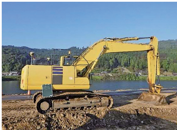
バックホウ (ICT 施工対応型) (参考)
