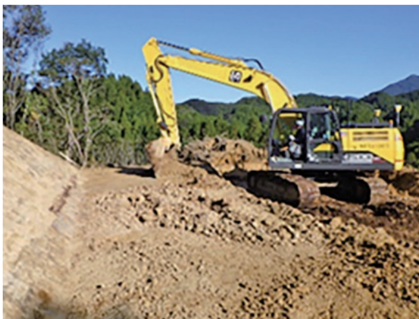
床掘作業状況
