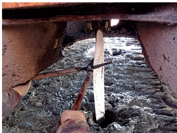
ドレーン材の切断作業状況
