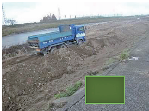
ダンプトラックによる運搬状況
