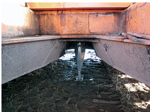
アンカー先端部
