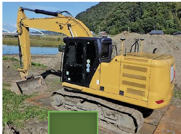
バックホウ (ICT 施工対応型) (参考)
