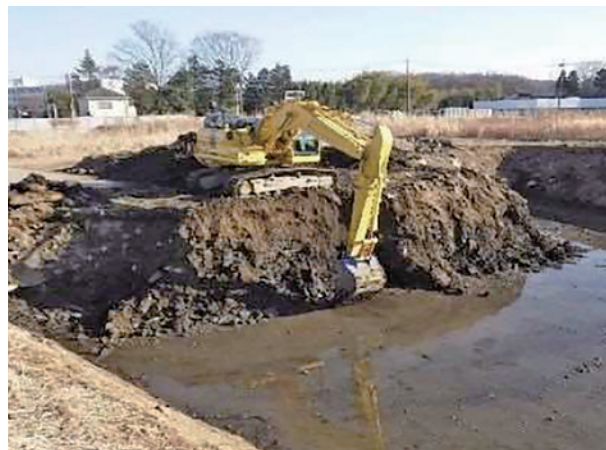
掘削作業状況
