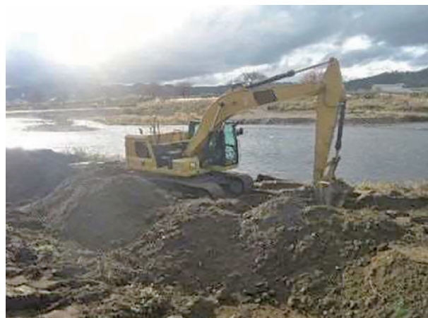
掘削作業状況
