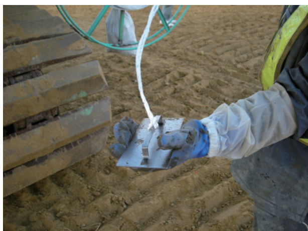
アンカー先端部
