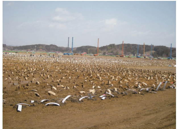
プレファブリケートッドバーチカルドレーンの打込作業完了状況
