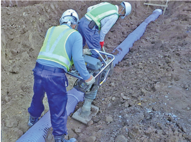
埋戻し作業状況（管路部）
