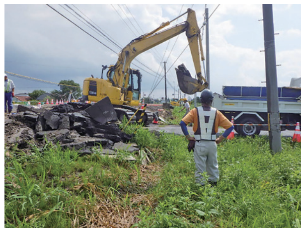
舗装版の破碎作業状況
