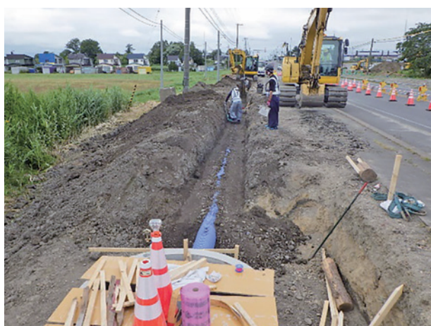
埋戻し作業状況
