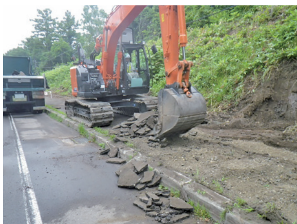
舗装版の破碎作業状況
