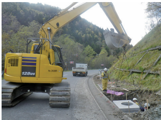
ハンドホール設置作業状況
