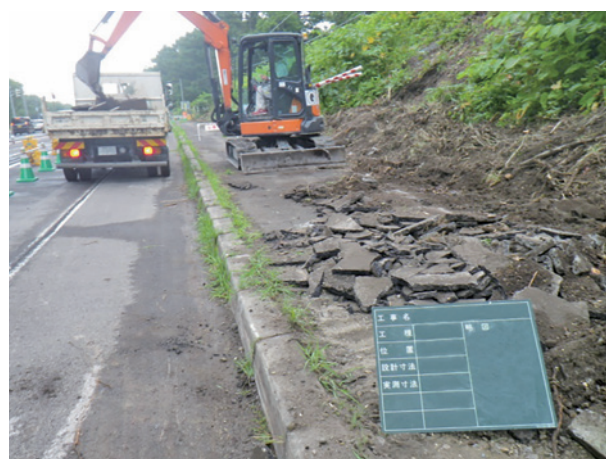
舗装版の破碎作業状況
