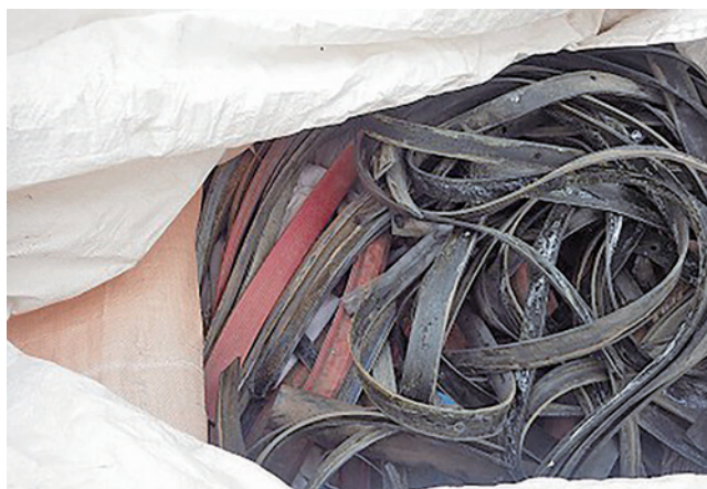
ノンスリップ撤去作業状況
