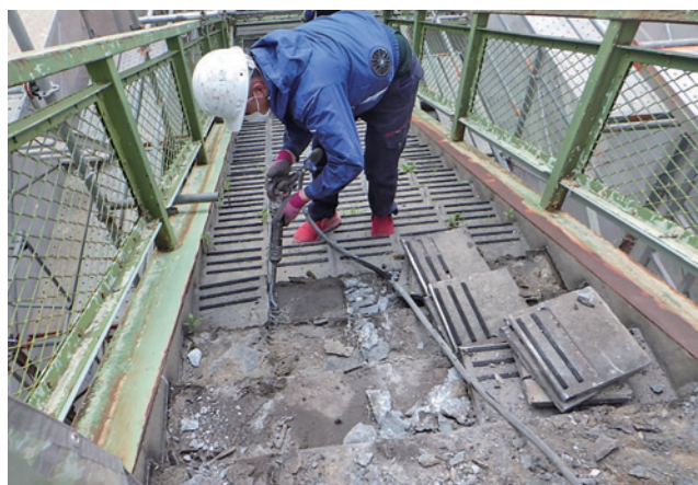
ノンスリップ撤去作業状況
