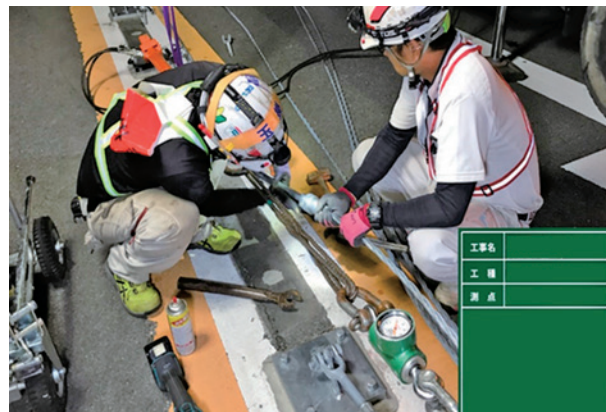
ターンバックル設置作業状況
