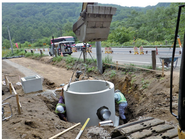
ハンドホール設置作業状況
