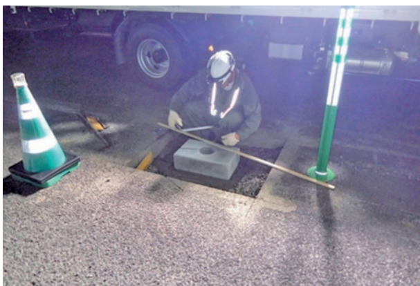
根固めブロック設置作業状況
