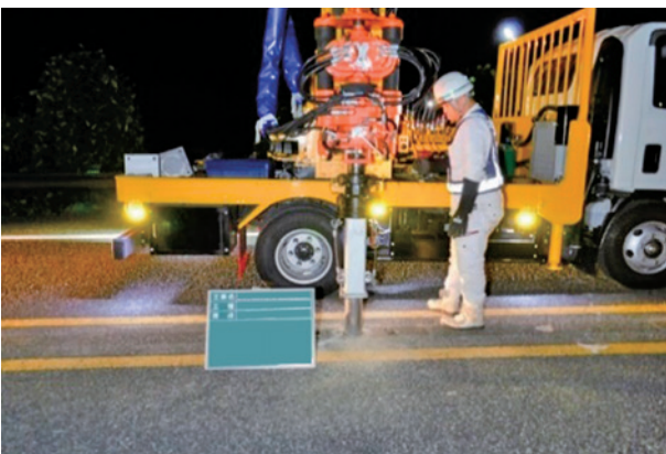
スリーブ管設置作業状況
