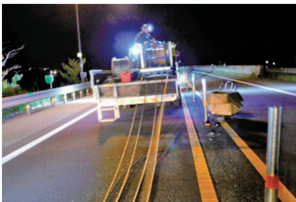
ワイヤロープ設置作業状況
