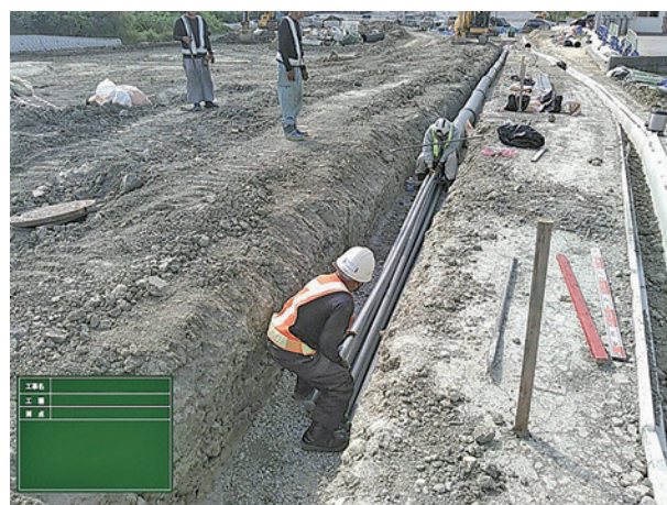
本体管設置作業状況
