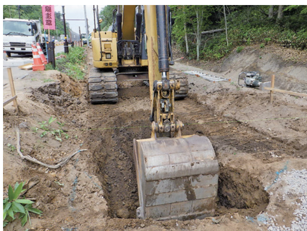
床掘り作業状況
