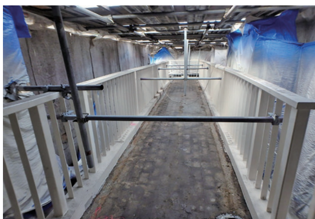
施工完了状況（床版撤去）
