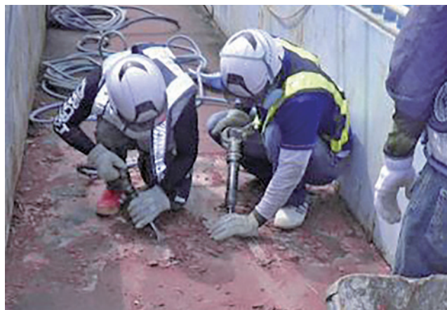
既設舗装はぎ取り作業状況
