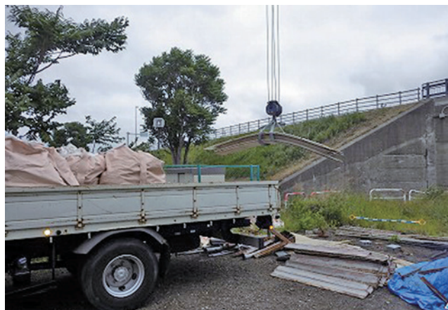
廃材積込作業状況
