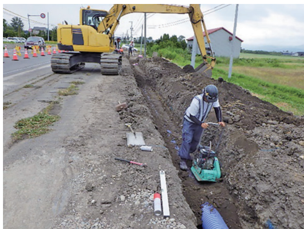
埋戻し作業状況
