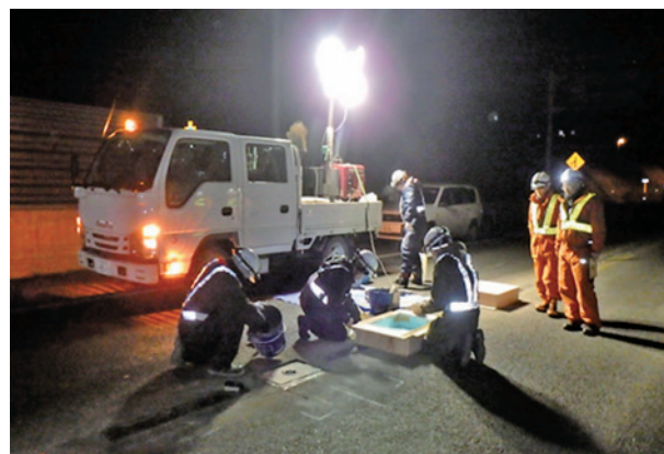
根固めブロック設置作業状況
