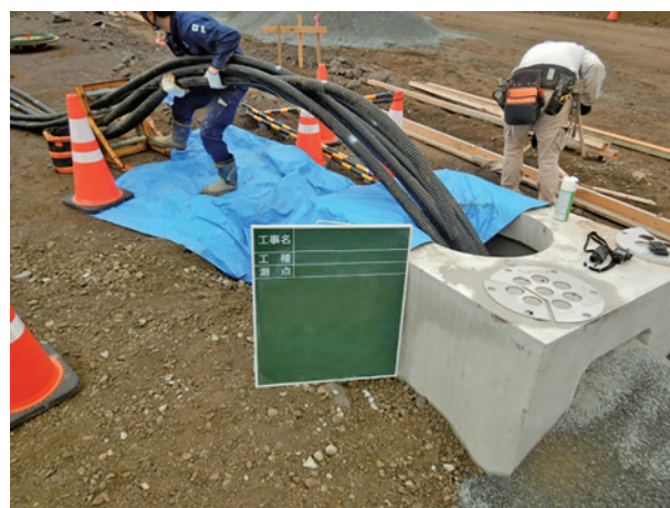
さや管設置作業状況
