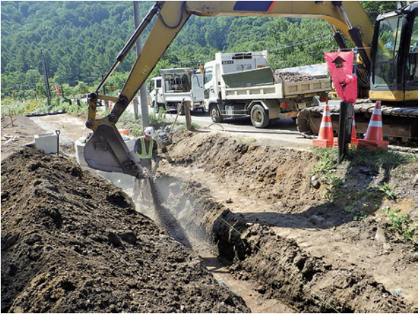
埋戻し作業状況（管路部）
