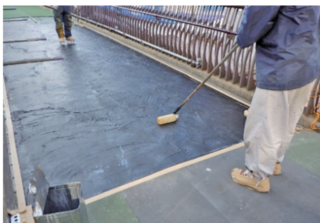
プライマー塗布作業状況（参考）
