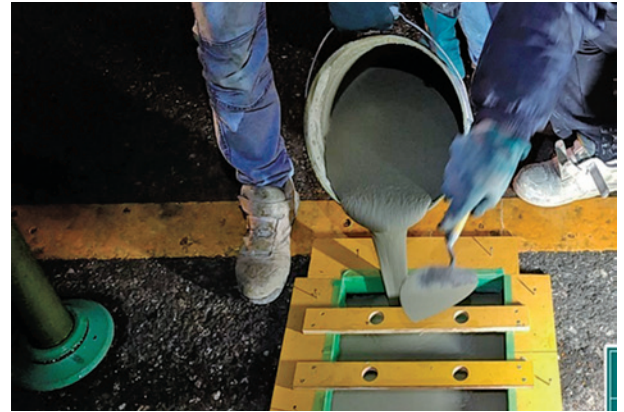
橋梁部基礎設置作業状況
