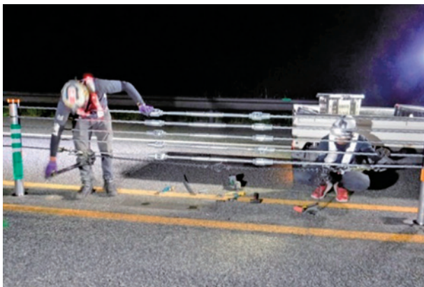
ターンバックル設置作業状況
