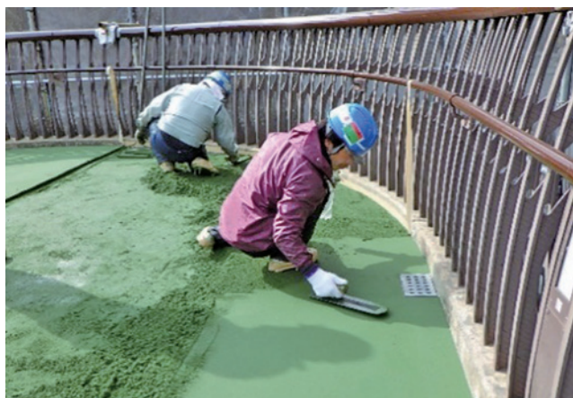
舗装材敷設作業状況（参考）
