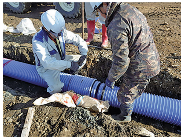
本体管設置作業状況
