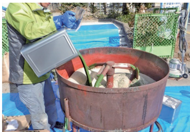
舗装材混合作業状況（参考）
