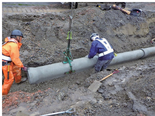
本体管設置作業状況
