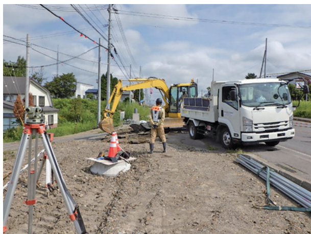
舗装版の破碎作業状況
