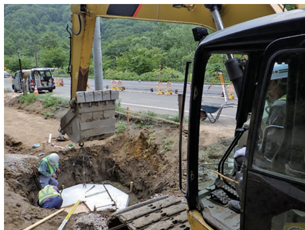
ハンドホール設置作業状況
