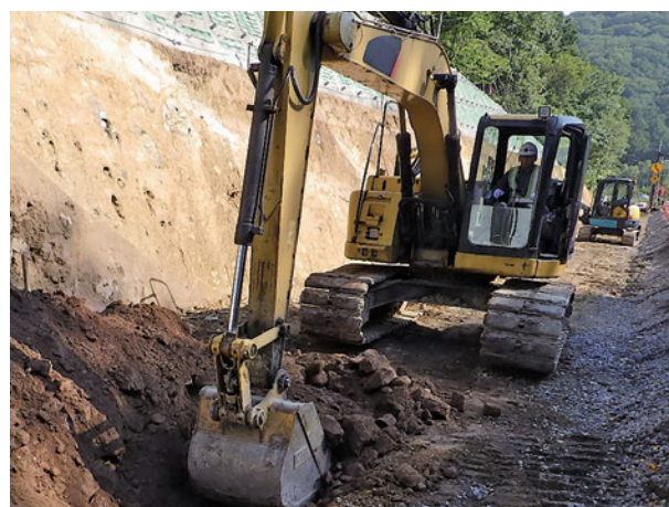
床掘り作業状況
