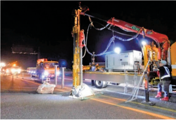
工事施工状況（全景）
