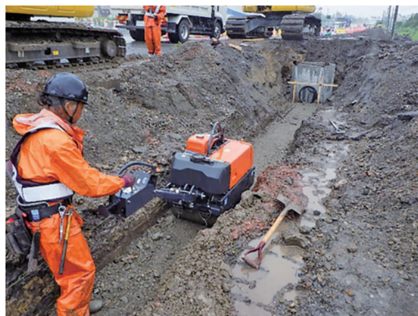
埋戻し作業状況
