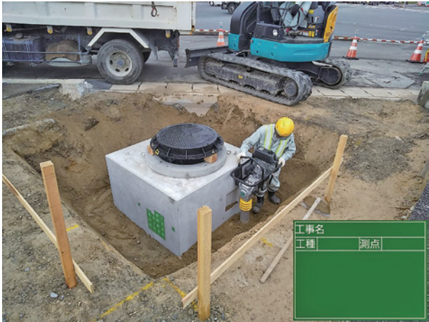
埋戻し作業状況（特殊部）
