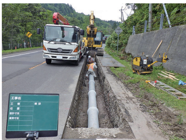
本体管設置作業状況
