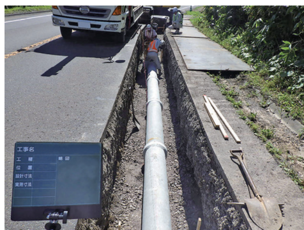
本体管設置作業状況
