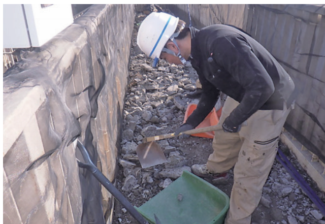
既設舗装はぎ取り作業状況
