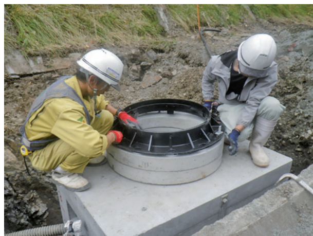
ハンドホール設置作業状況
