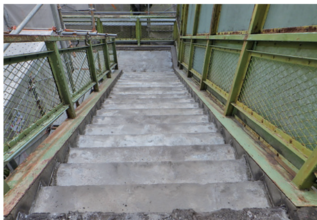
施工完了状況（ノンスリップ撤去）
