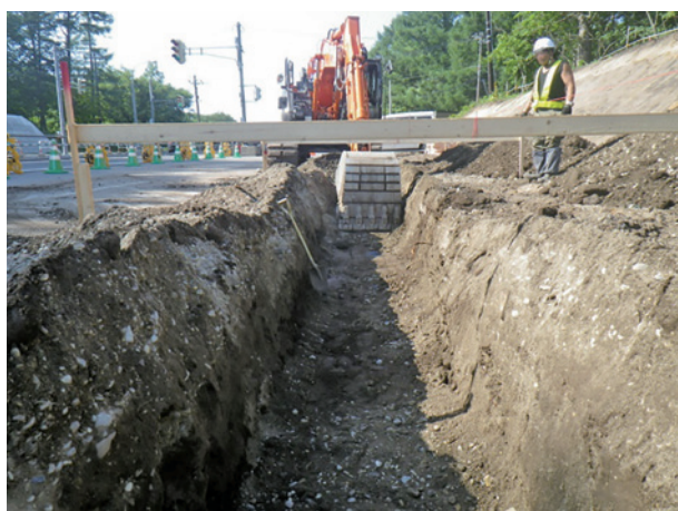
床掘り作業状況
