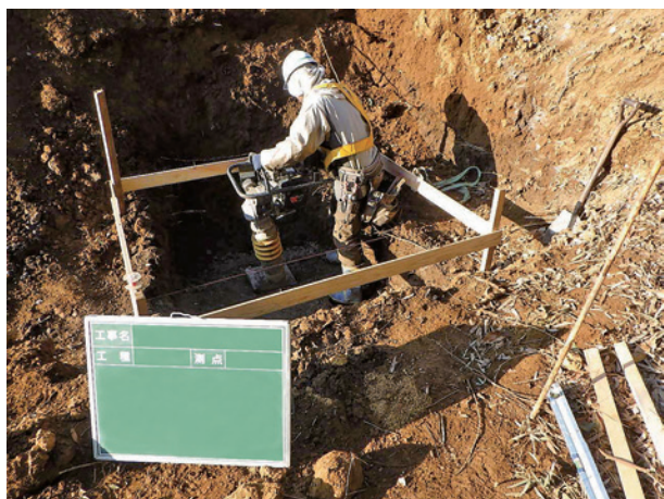
基礎碎石の転圧作業状況
