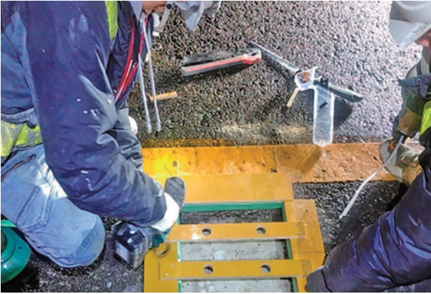
橋梁部基礎設置作業状況
