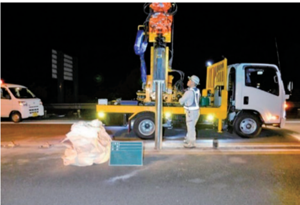
鋼管杭端末基礎設置作業状況
