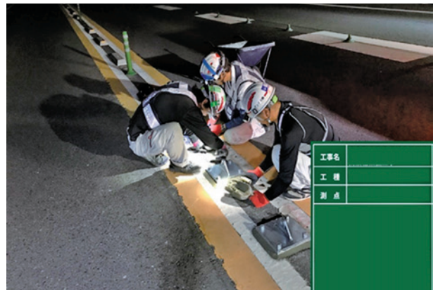
鋼管杭端末基礎設置作業状況
