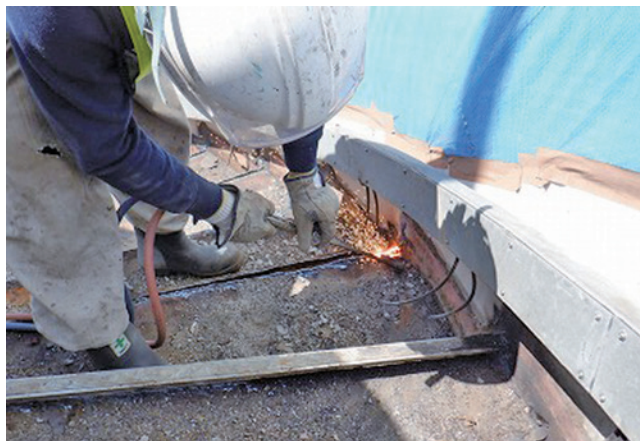
ノンスリップ撤去作業状況
