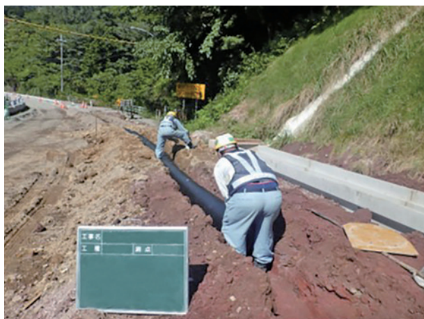
本体管設置作業状況
