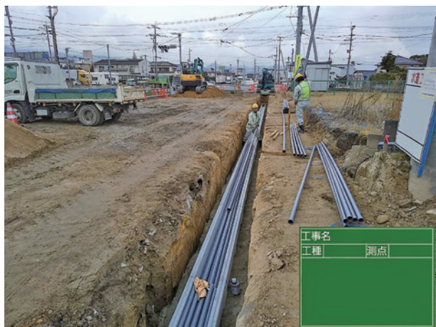
本体管設置作業状況
