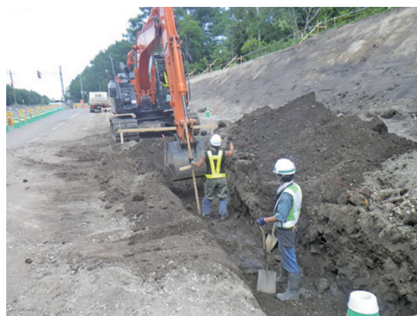
床掘り作業状況
