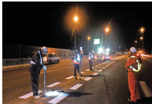
中間支柱・端末支柱設置作業状況
