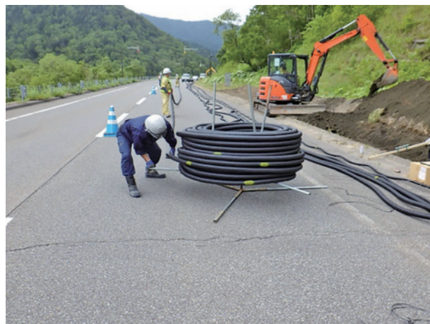
さや管設置作業状況
