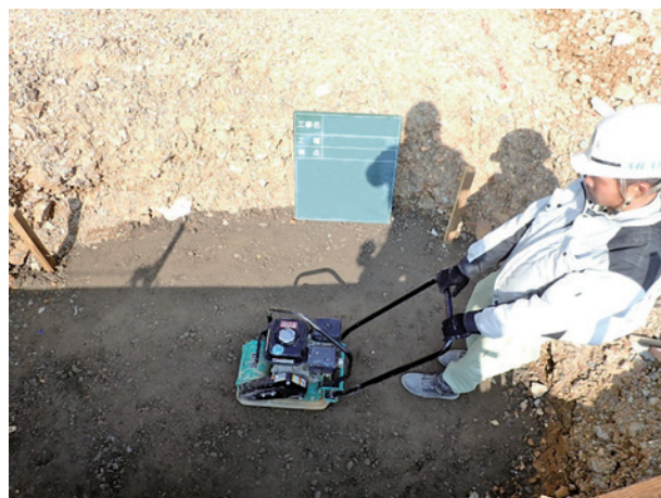
基礎碎石の転圧作業状況
