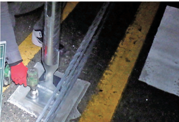
橋梁部支柱設置作業状況
