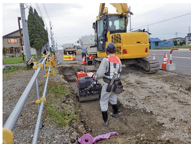
埋戻し作業状況
