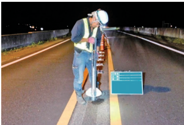
中間支柱・端末支柱設置作業状況
