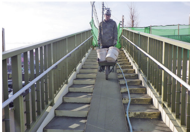
既設舗装はぎ取り作業状況
