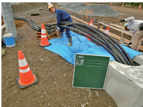
さや管設置作業状況
