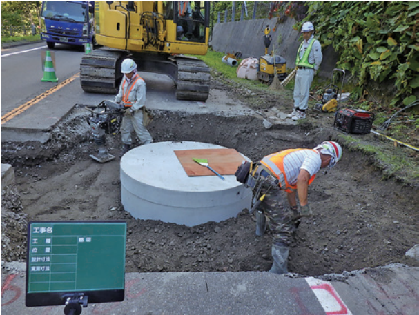
埋戻し作業状況（特殊部）
