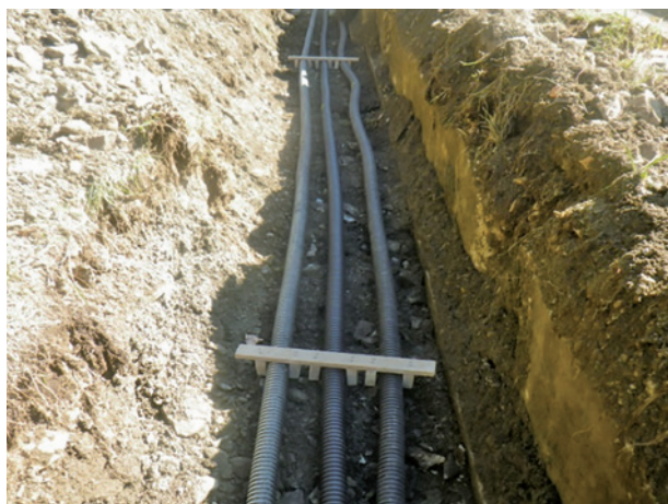
さや管設置状況
