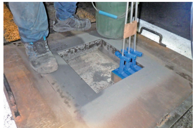
橋梁部支柱設置作業状況
