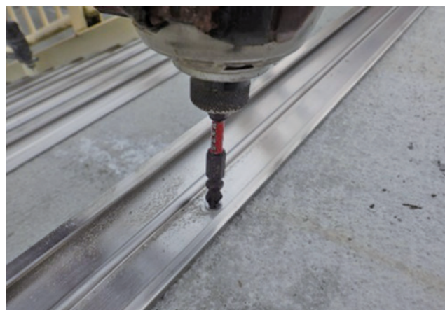
ノンスリップ金台設置作業状況（参考）
