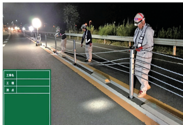
ワイヤロープ設置作業状況
