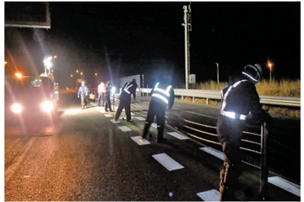
工事施工状況（全景）
