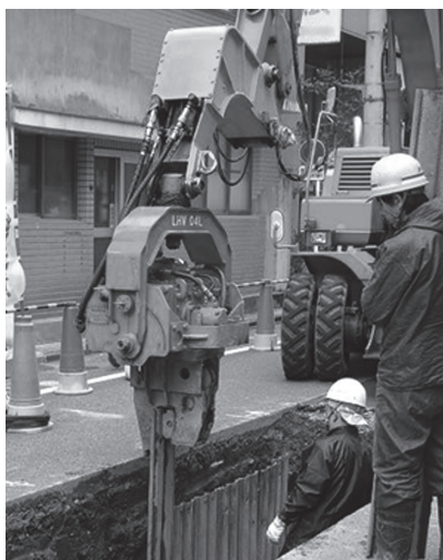
軽量鋼矢板パイプロハンマ打込状況
