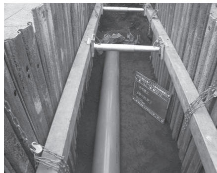
塩ビ管布設状況
