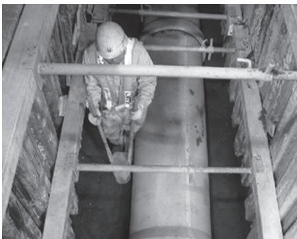
鉄筋コンクリート管布設状況
