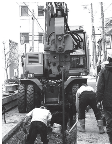
軽量鋼矢板パイプロハンマ引抜き状況
