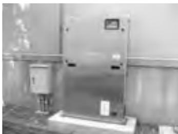
写真4.3.1 住棟妻壁に設置の増圧ポンプユニット
