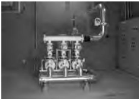
②-3 発電機室内に新設圧送ポンプユニット設置（制御盤部）
