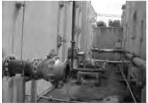
④ 受水槽から新設圧送ポンプユニットへの給水配管と既存給水主管までの吐出配管工事
