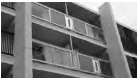
写真6.1.3 太陽光温水パネルと太陽光発電パネルによる給湯システム。外側は構造補強フレーム。
