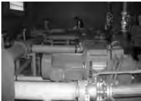
②-2 発電機室内に新設圧送ポンプユニット設置（ユニット型ポンプ部）
