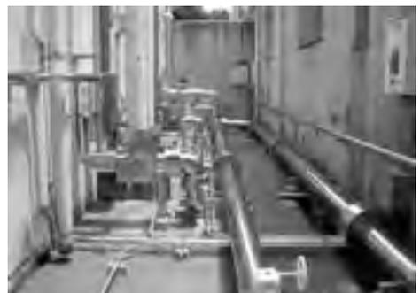
⑦-1 不要となった既存給水装置・制御盤類及びポンプ室内配管・配線類の撤去を行う。
