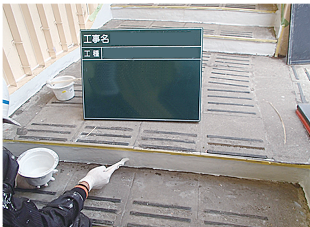
⑦ 塗装作業
