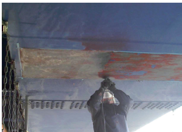
①上部ブラケット取付部芯出し調整
