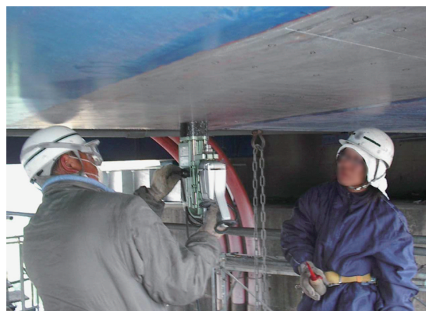
②主桁部孔明け
