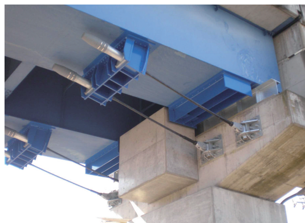
⑥ケーブル取付け
