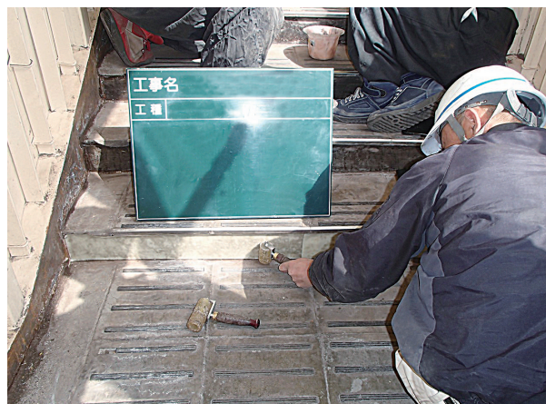
④ FRP シート設置
